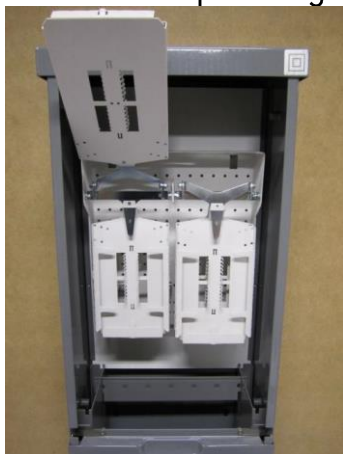
Figur 20, Exempel på skarvskåp i byggnad
